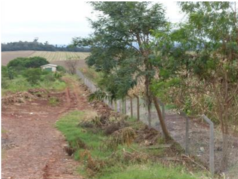
Figura 5 - Cercamento do Perímetro do Aterro
