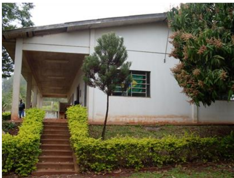
Figura 9 - Escritório da Usina de Reciclagem
