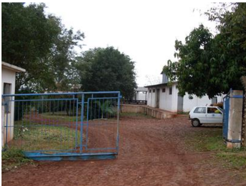
Figura 4 - Portão de Entrada do Aterro
